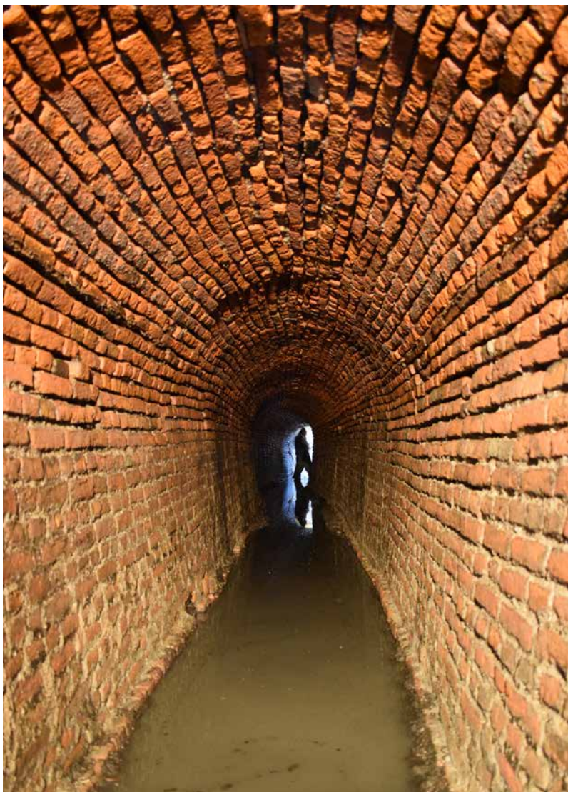
Herstel en toegankelijk maken overkluisde waterloop 't Glop
